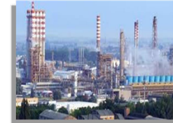
Centrale Termoelettrica a gas naturale ENI - SAIPEM Ferrara
