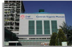
Centrale Termoelettrica a carbone "Eugenio Montale" ENEL La Spezia
