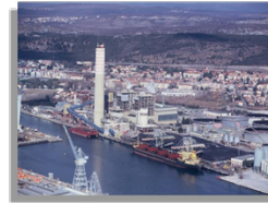
Centrale Termoelettrica a carbone A2A Monfalcone - Gorizia
