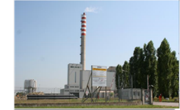
Termovalorizzatore HERA Ferrara
